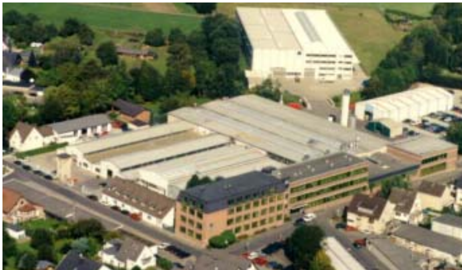
Produktions- und Verwaltungsgebäude der Hennecke GmbH in St. Augustin Birlinghoven an der Birlinghovener Straße
